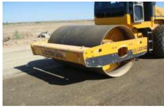
**Рис. 1. Укрепление грунтового основания на а/д «Таукент – рудник Канжуган – рудник Мойынкум»:**
